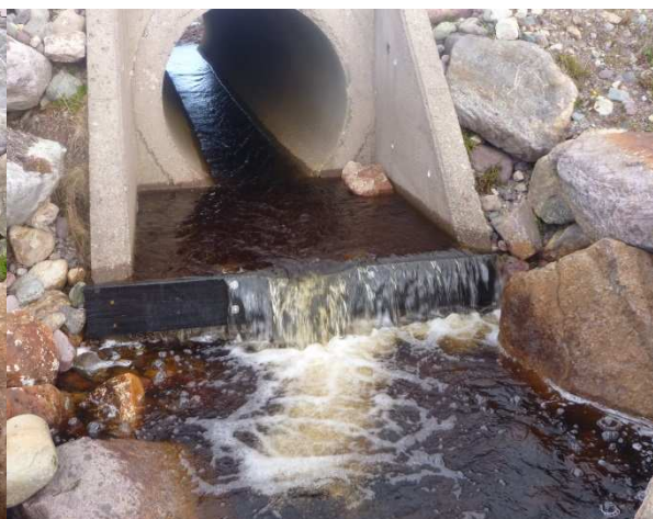
Figure 15 : buse de la Pointe au Cheval après travaux
