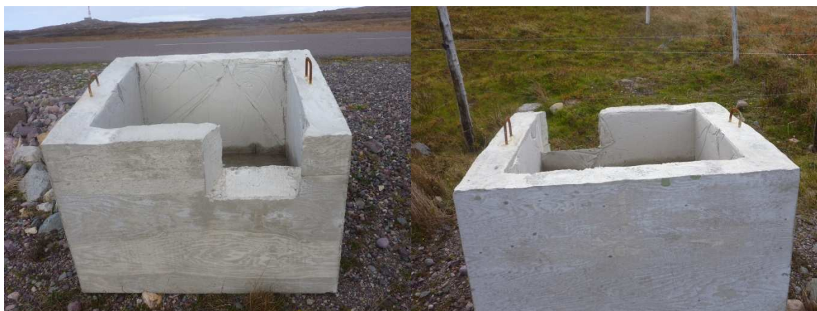
Figure 18 : bac en béton qui sera posé en 2014
