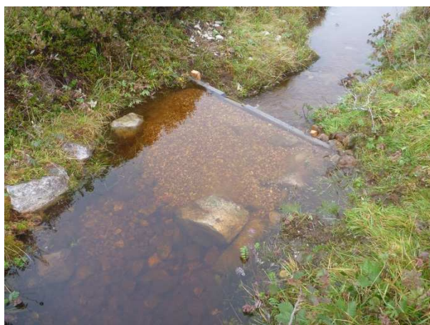
Figure 5 : Seuil à vocation piscicole au Pain de Sucre (St-Pierre)
