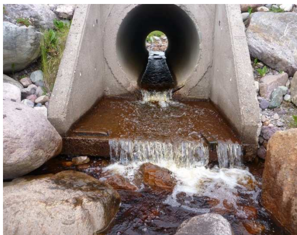
Figure 14 : buse de la Pointe au Cheval avant travaux
