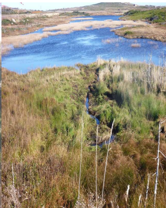
Figure 11 : Ruisseau des Herbiers après les travaux (St-Pierre)
