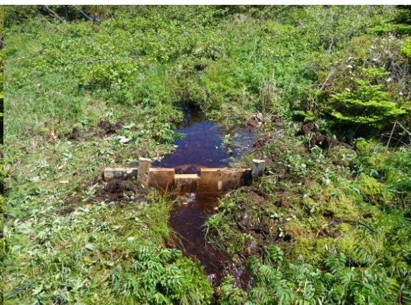
Figure 4 : Seuil à vocation piscicole Anse à Pierre (St-Pierre)
