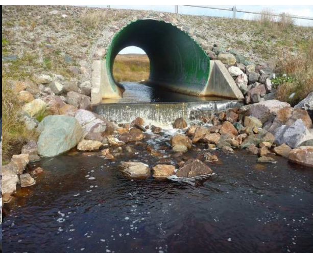
Figure 17 : Buse de la Mère Durand après travaux
