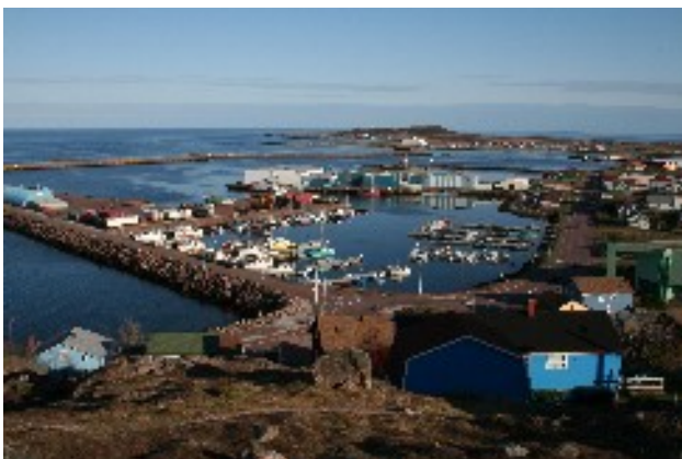
Le port de Saint-Pierre, photo : DE 975
