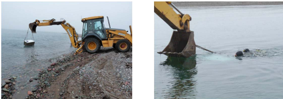
Figure 12 : Courantomètre vertical : finalisation de la mise à l'eau du dispositif; un tracto-pelle met le sarcophage à disposition des plongeurs qui transportent celui-ci jusqu'au coffre (qu'ils ont pré-positionné et évidé) à l'aide d'un parachute.
