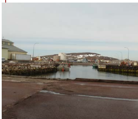
Vue depuis les abords du quai d'arrivée
