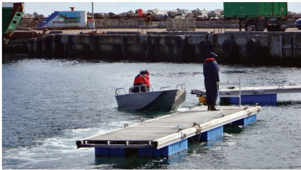
L'Antenne de Miquelon gère l'exploitation du port local, en lien avec les services de Saint-Pierre. Les agents de l'atelier Quais entretiennent les infrastructures, comme les appontements flottants remisés pour l'hiver.
