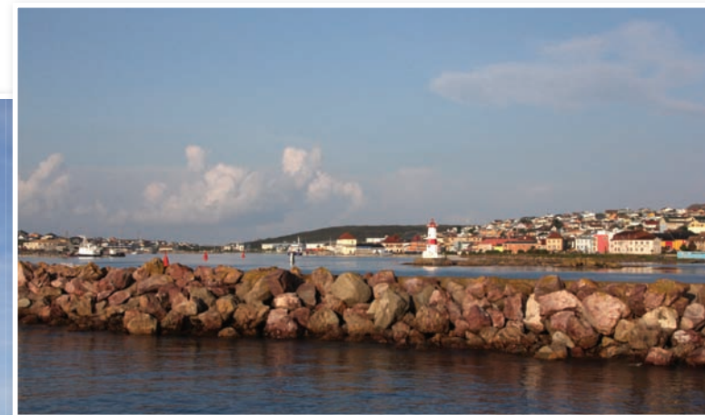
Au programme des travaux 2018, la rénovation des digues du port de Saint-Pierre, très exposées en période hivernale.
