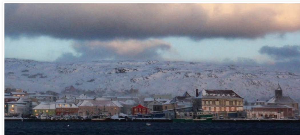
La nouvelle gare maritime de Saint-Pierre qui sera inaugurée en 2017 devrait accueillir les deux nouveaux ferries dont la livraison est prévue en novembre. En parallèle de la construction de la gare, la DTAM proposera un aménagement des quais et des aires adjacentes.
