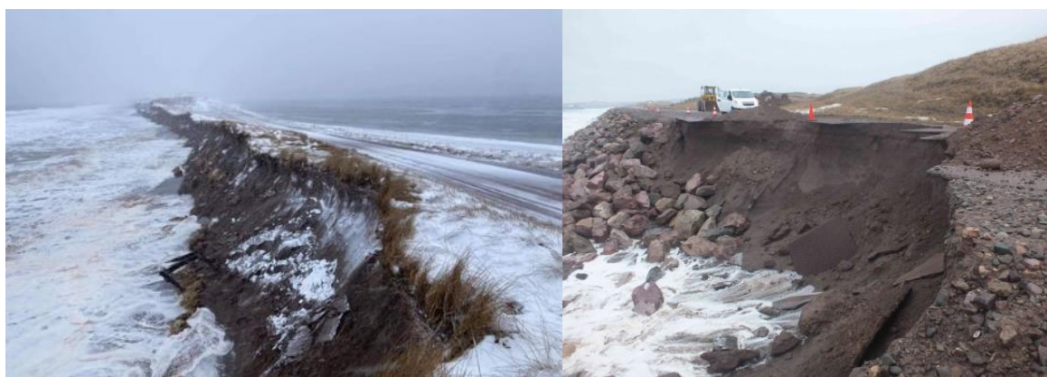
Illustration 11 – Erosions constatées au PK16 (en bas à gauche- source SPM 1ere) et au PK16+300 (en bas droite – source DTAM)
