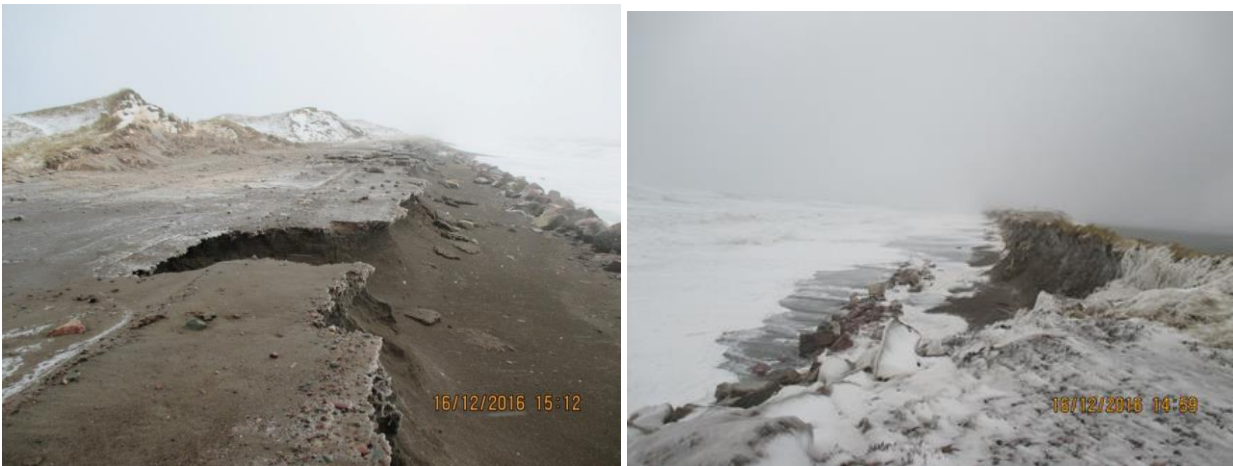
Illustration 9 – Erosion du talus en 2016 (photos DTAM au PK17 à gauche et PK18 à droite)
