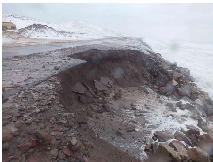
Illustration 14 – Nouvelle encoche d'érosion et affaissement de la route au 03/03 (source DTAM)
