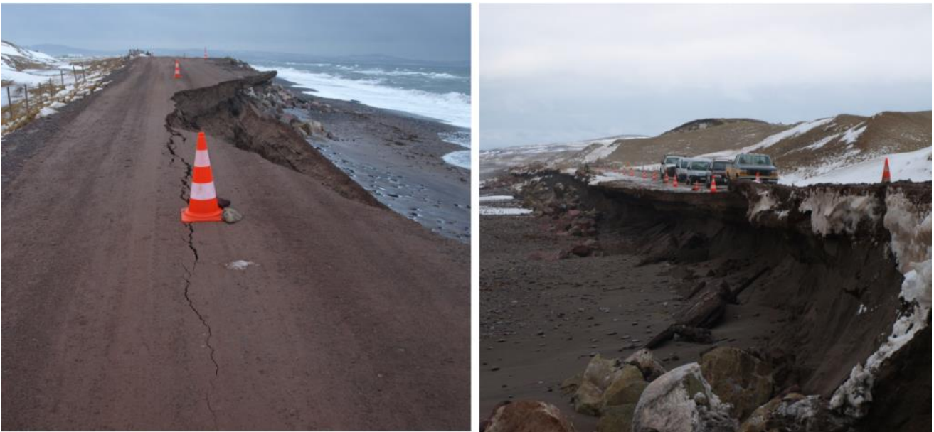
Illustration 8 – Erosion du talus en 2009 (photo DTAM au PK18)
