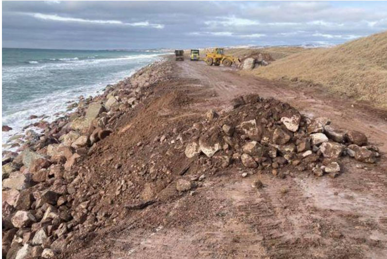
Illustration 12 – Travaux d'urgence réalisés pendant une fenêtre météo clémente (source SPM 1ere)
