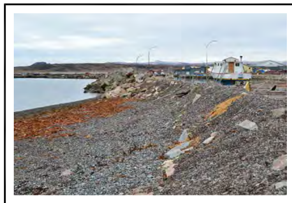
- BCR et Enrochements -
