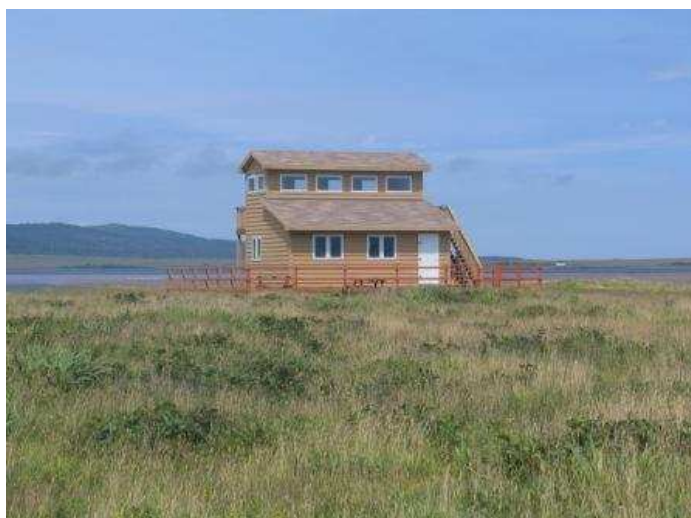
Poste d'observation des oiseaux et des phoques mis en place en 1997 au Grand Barachois
