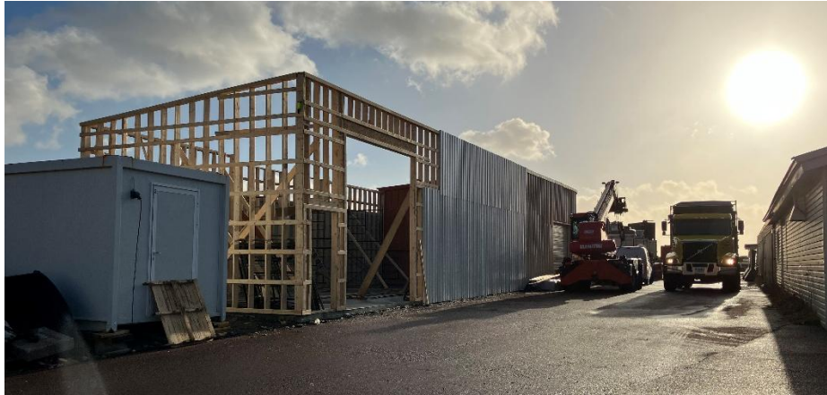
Figure 2 : Local de stockage en cours de construction
