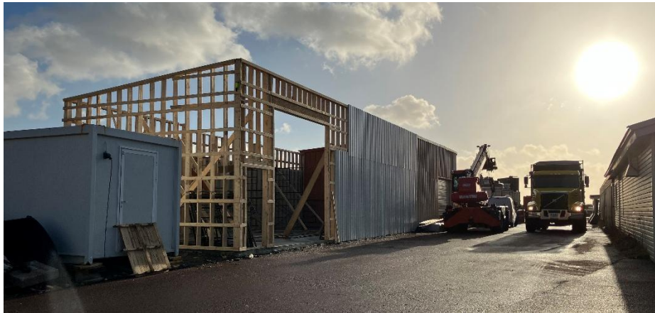
Figure 2 : Local de stockage en cours de construction
