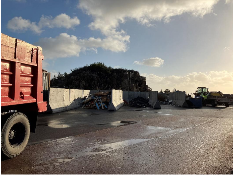
Figure 4 : Alvéoles de stockage
