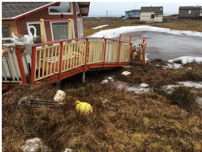
Petit Barachois - Habitations ayant subis des dégâts - Tempête du
