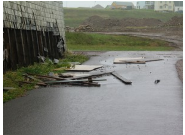
Digue du Barachois le 13/09/2006 à 15h21 - source DE -
