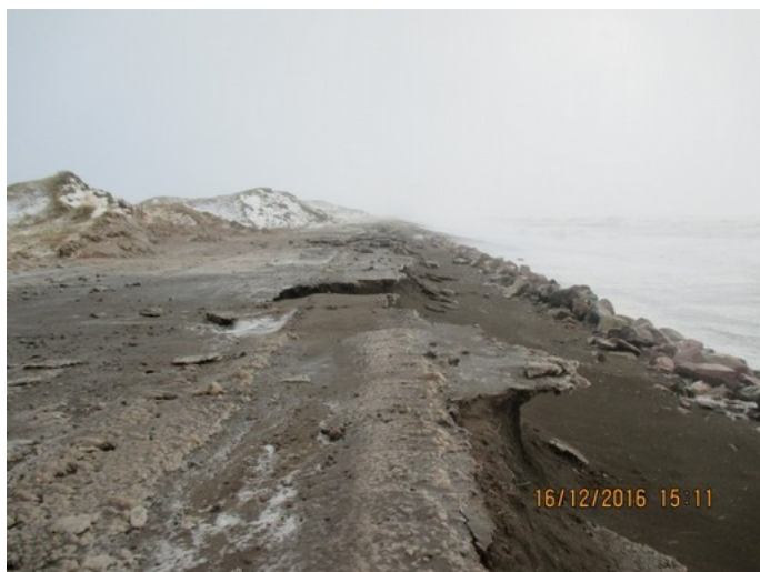
Route Buttereaux - Affaissement accotement au niveau du PK17 - tempête 16/12/2016 - Source DTAM- du 16/12/2006 - Source DTAM
