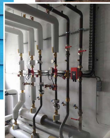
Réfection des circuits de chauffage du district routier
