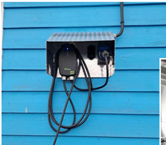
Pose d'une borne de recharge pour voiture électrique au parc de la DTAM à Saint-Pierre
