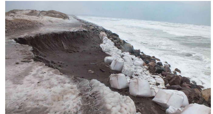
Pose de big-bags dans le cadre du suivi de l'érosion de l'isthme
