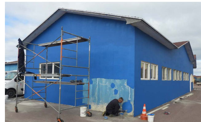
Réfection des façades de l'atelier mécanique
