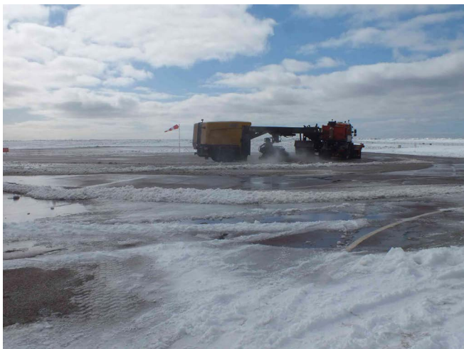
Déneigement de la piste de l'aérodrome
