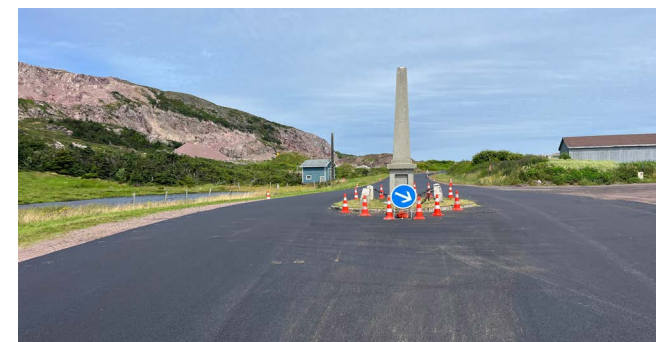
Enrobés réalisés sur la Route Nationale 1
