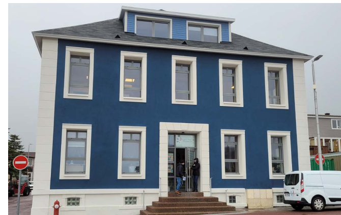
Réfection des façades du Palais Royal
