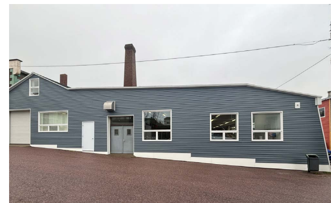
Réfection des façades des ateliers bois et fer
