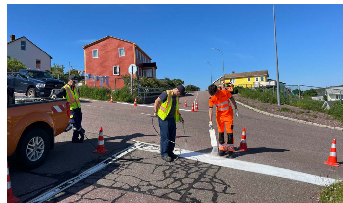
Mise en peinture de la signalisation horizontale
