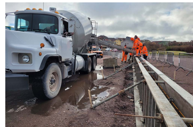
Coulage d'un muret pour l'entourage du parc à Saint-Pierre
