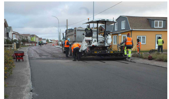
Suivi des chantiers d'enrobés réalisés dans le village de Miquelon
