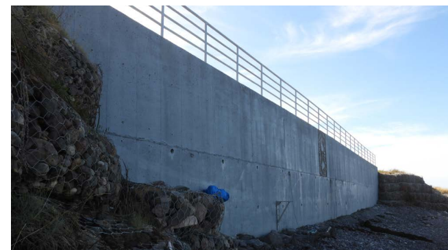
Entretien du mur situé à l'Anse à Yvon
