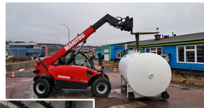
Installation d'une nouvelle cuve à carburants dédiés aux engins
