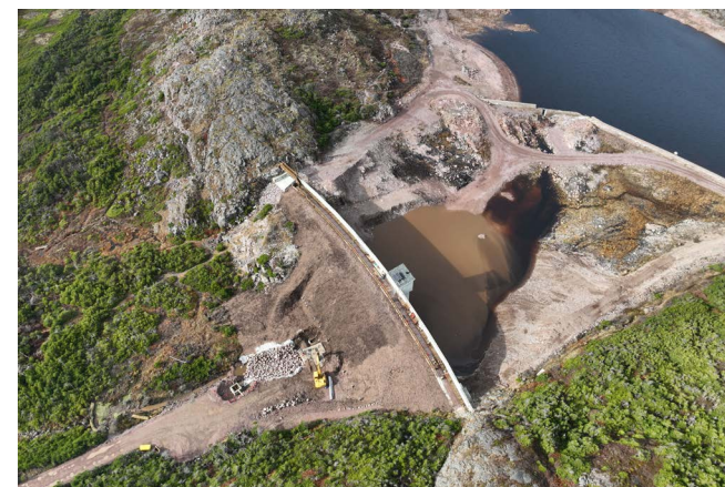
Chantier de reconstruction du barrage de la Vigie
