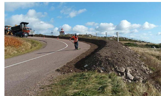
Mise en place d'un merlon de protection sur la route de Galantry
