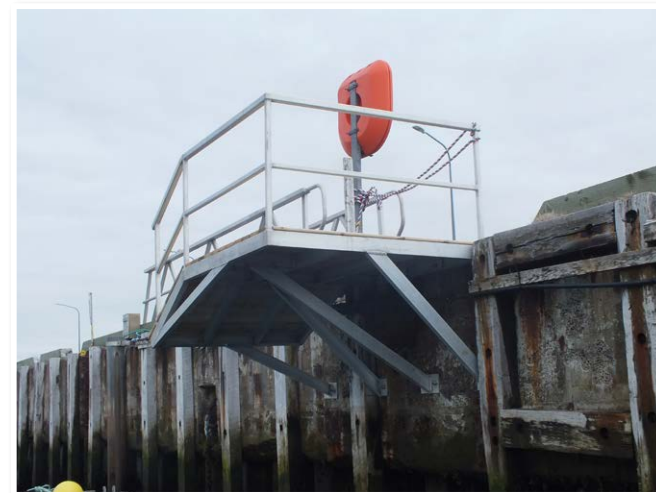
Une passerelle en aluminium entièrement réalisée par l'atelier quais.
