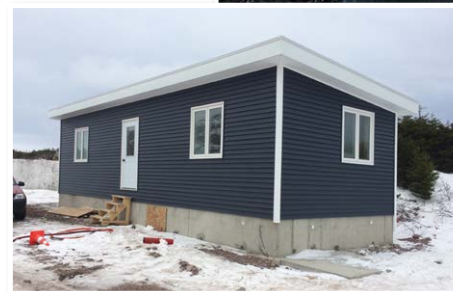
Le nouveau local « hydrocureur » construit sur la route de Savoyard
