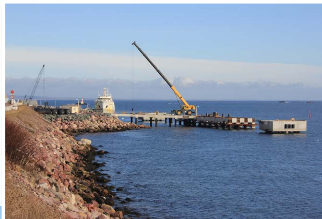
La fin du chantier du quai de croisière en novembre 2021. L'ancien quai en eau profonde ayant été conservé, l'approvisionnement maritime n'a pas été interrompu.
