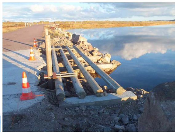
Installation de glissière en bois sur le dalot de la route de Mirande.
