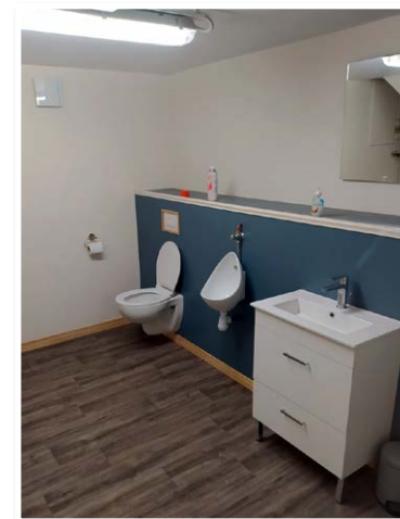
La rénovation des locaux du district routier réalisée en régie par les ateliers et les agents du district.
