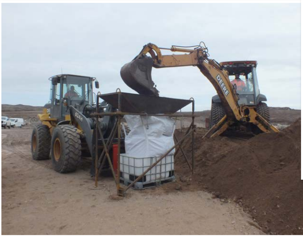
Une trémie a été fabriquée spécialement par l'antenne de Miquelon pour faciliter le remplissage des big bags utilisés pour protéger l'isthme.
