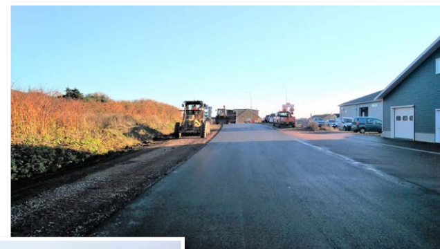
Exemple de chantier réalisé en 2021, la réfection d'une section de la RN1 vers Savoyard.
