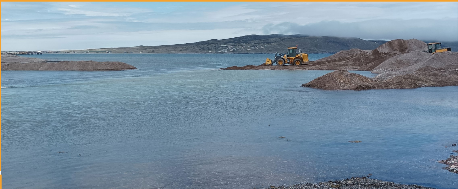
Travaux de redressement au Goulet du Grand étang à Miquelon.
