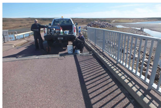
Travaux sur le pont du Goulet à Miquelon.
