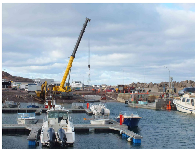
Plusieurs chantiers se sont déroulés sur le port de Miquelon en 2022.
