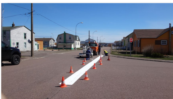
Les équipes de l'atelier routes sont en charge du marquage au sol dans le village de Miquelon.
