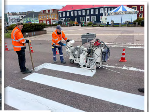
Les agents assurent la pose de l'ensemble de la signalisation horizontale à Saint-Pierre.
