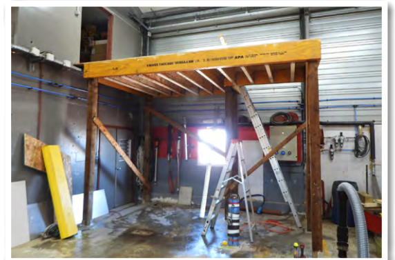
Construction d'un escalier d'accès dans le hangar de l'aérodrome.
