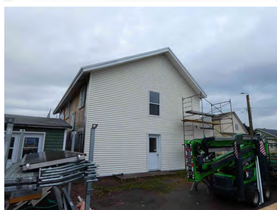
Rénovation énergétique de l'antenne de Miquelon, réalisée avec des crédits issus du fonds vert.
