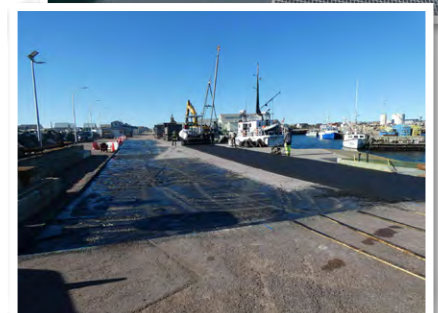
Remplacement des échelles, et mise en enrobés du quai Avel Mad.
