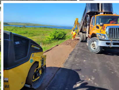
Remise à niveau des accotements de la route de Savoyard.
