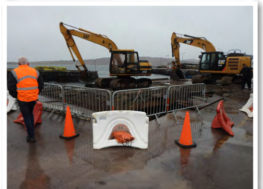
Confortement des cellules du quai Avel Mad.
