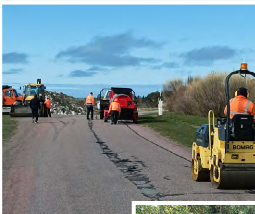
Réfection des routes avec le recycleur et des nids de poule.
