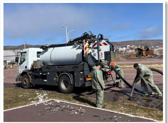
Intervention avec le camion hydrocureur.
