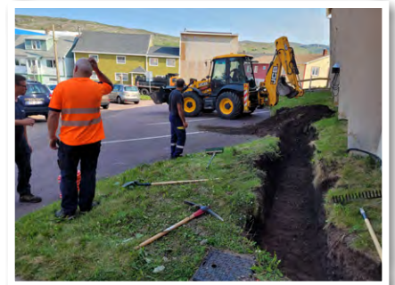
Le district routier a participé à l'installation de la borne de recharge pour voiture électrique en creusant une tranchée pour passer les câbles nécessaires.
