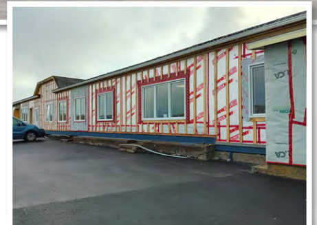
Réhabilitation des façades de la Maison de l'Enfant et rénovation thermique du district routier.
