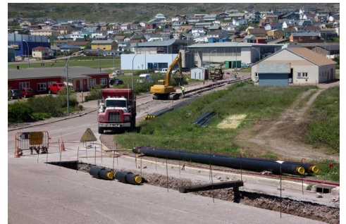
La DTAM a suivi et a veillé au maintien d'une bonne signalisation lors du chantier du réseau de chaleur pour assurer la sécurité de tous.
