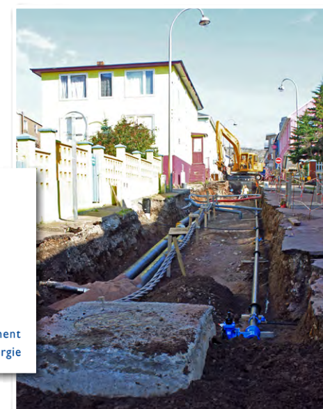
Les travaux de réalisation du réseau de chaleur reliant les bâtiments collectifs
