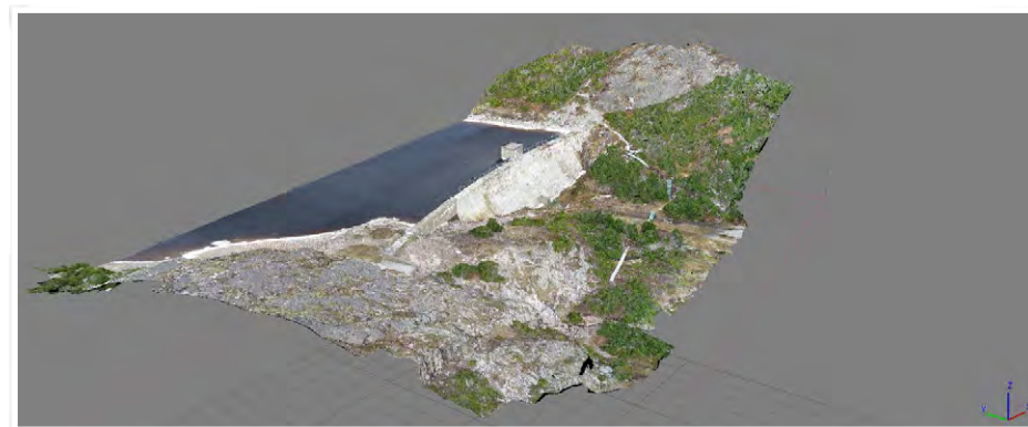
Diagnostic visuel 3D du barrage de la Vigie obtenu par interprétation des images acquises par drone.
