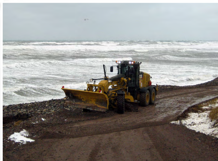
De fortes tempêtes ont frappé l'archipel à l'automne 2018, causant des inondations et dégâts importants sur le littoral.
