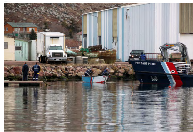
Installation d'un ponton pour l'accueil des croisiéristes, au plus près des salines du port de pêche traditionnel. Les équipes des services maritimes travaillent de concert : plongeurs, phares et balises, ateliers quais...
