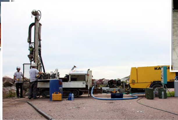
Réalisation des essais géotechniques pour déterminer la nature du sol et la distance du socle rocheux pour l'ancrage du futur quai en eau profonde.
