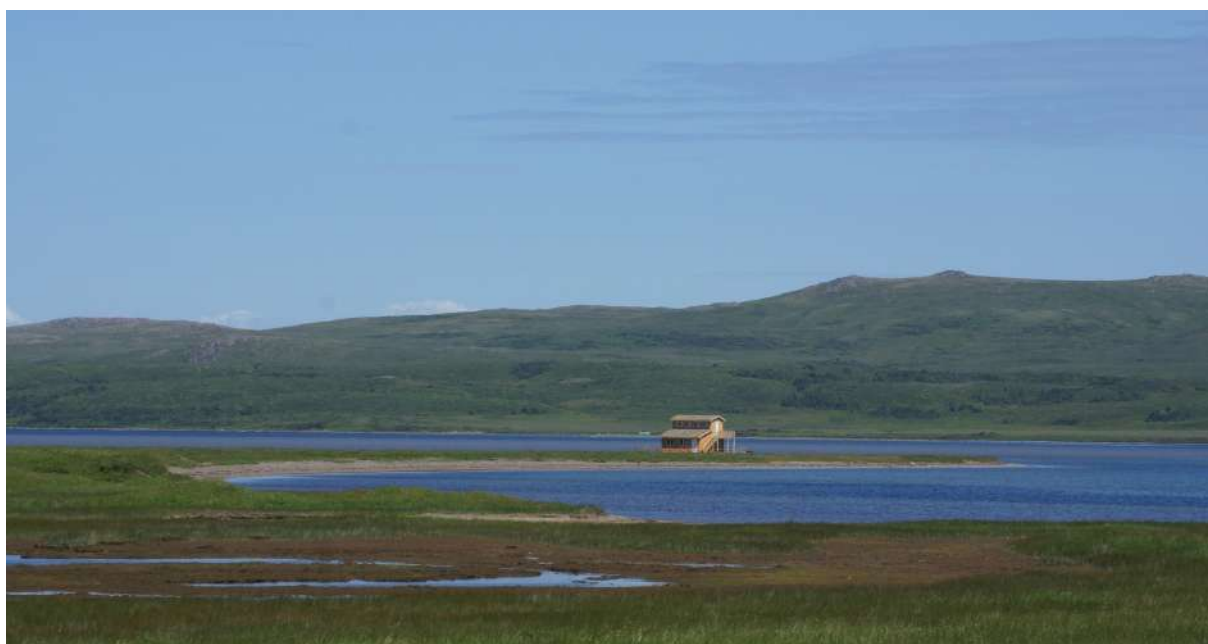
Observatoire de la Pointe aux Barges, Grand Barachois, Miquelon. © Laurent JACKMAN
