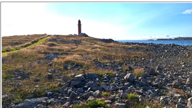
- Blocs rocheux au niveau du phare -
