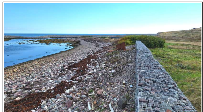
- Gabions (partie Sud) -
