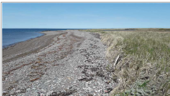
- TDC partie Nord -
