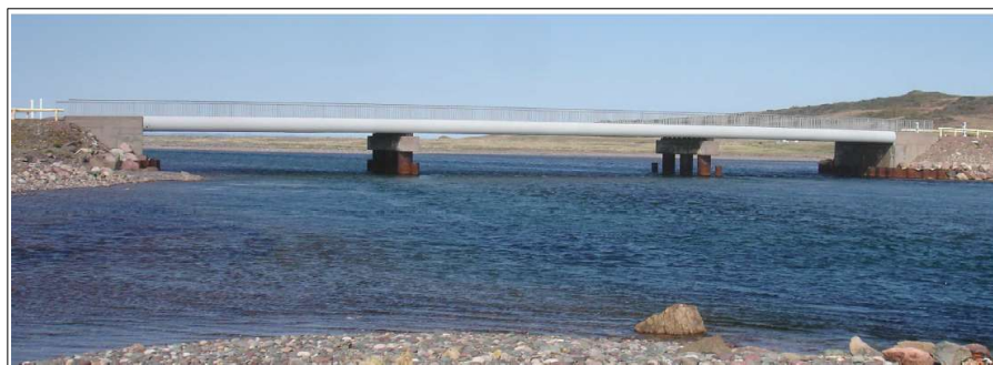
- Pont construit en 2002 -
