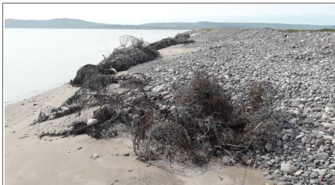
- Gabions éventrés et enfouis -
