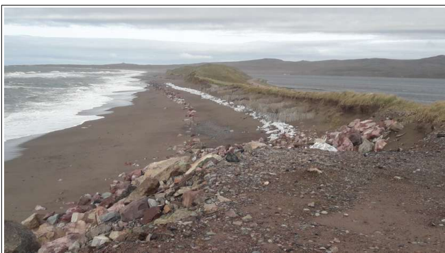
- Partie Sud des butteaux protégée par des Big Bags -
