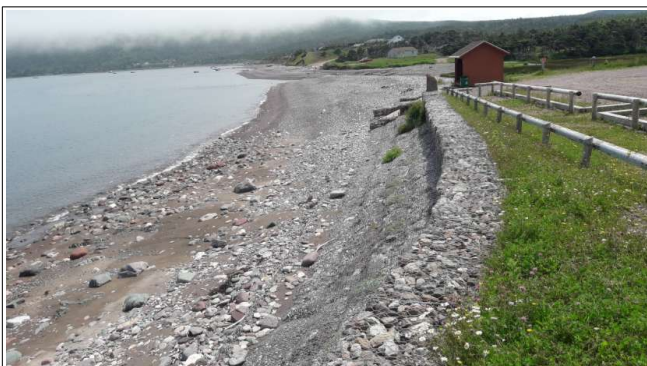
- TDC Nord, renforcement du parking par des gabions -
