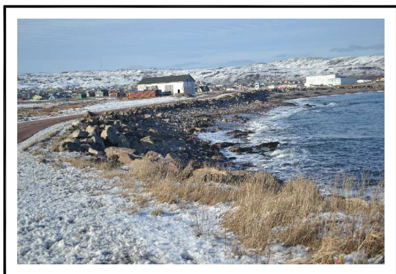
- Démarrage TDC au SUD - (au niveau du STOP du carrefour de Galantry)
