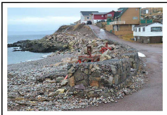
- Enrochements et Gabions - (Partie Nord)
