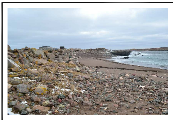
- Enrochements partie Nord -
