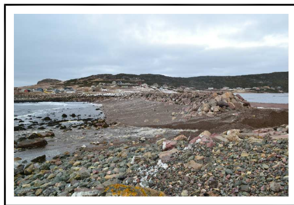
- Enrochements partie sud -
