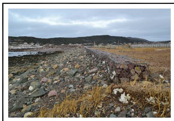
Gabion : Cage de fil de fer tressé remplie de pierres
