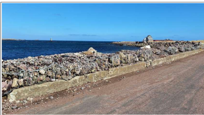
- Gabions et muret (Ouest du TDC) -
