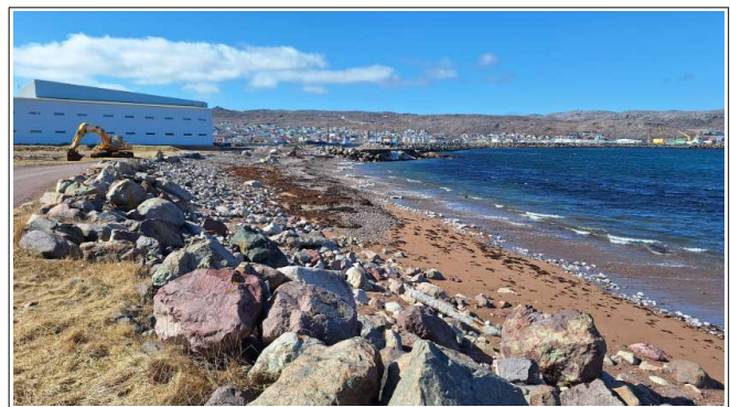
- Enrochements (Est de l'Anse à Bertrand) -
