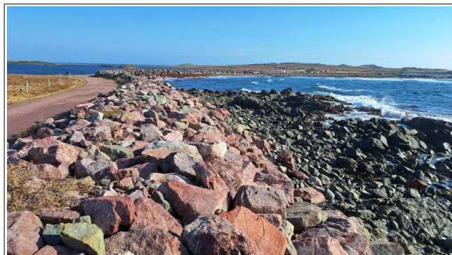
- Enrochements de la plage de Savoyard -
