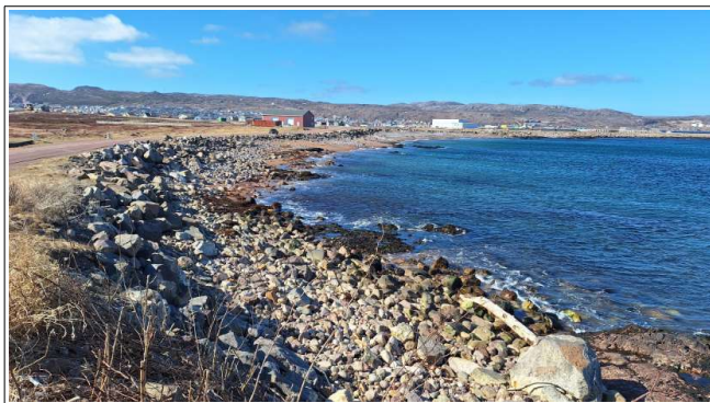
- Enrochement (Sud de l'Anse à l'Allumette) -
