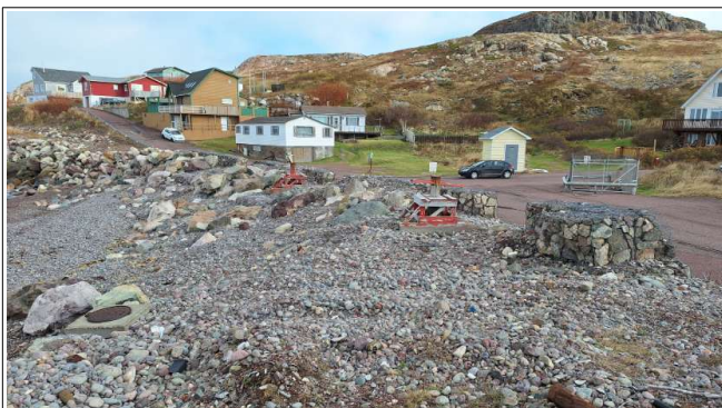
- Enrochements et gabions -
